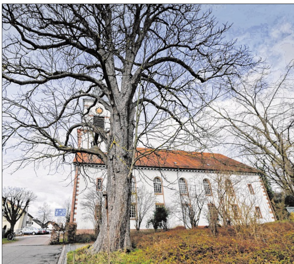
DIE GESUNDHEITLICH ANGESCHLAGENE Rosskastanie neben der evangelischen Kirche in Wössingen wird besonders beobachtet und gepflegt. Foto: wai
